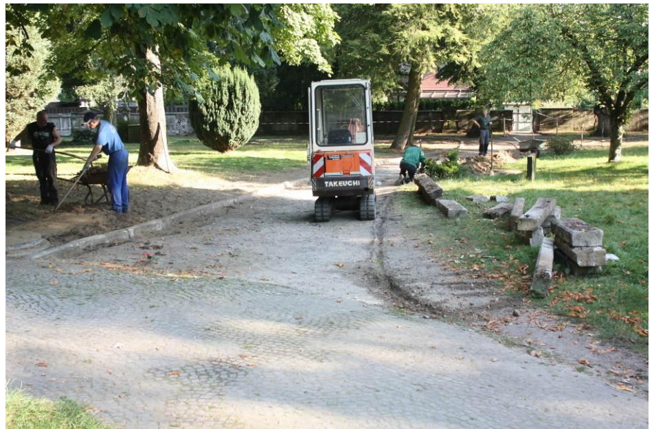
3. Abteilung Johannisfriedhof während der Arbeiten
